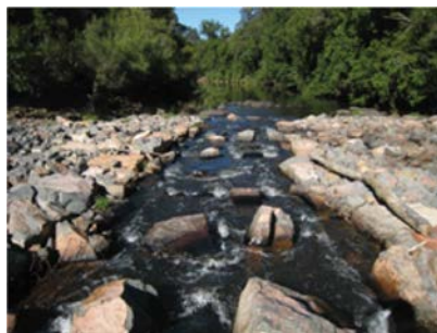
Slika 18.18: Riblja staza – rampa od kamena u delu korita (Izvor: fishhabitatnetwork.com.au)
