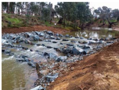
Slika 18.17: Riblja staza – rampa od kamena celom širinom korita (Izvor: mawsons.com.au)
