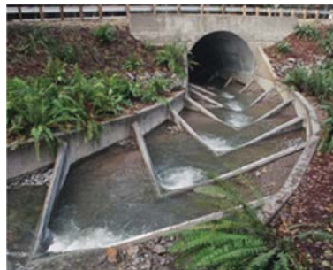
Slika 18.16: Tehničke riblje staze sa veštački povećanom rapavošću
