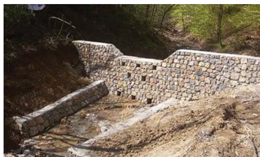
Slika 14.1: Bujična pregrada od kamena (Izvor: Srbijavode)
