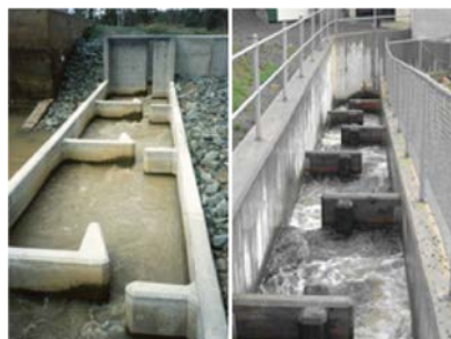
Slika 18.15: Tehnička riblja staza sa vertikalnim otvorima (Izvor: finterest.com.au)
