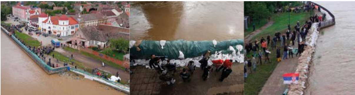
Slika 63: Nasip od vreća sa peskom
