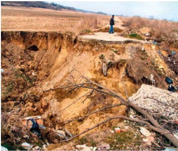
Slika 27: Put presečen bujičnom jarugom male ukupne denivelacije
