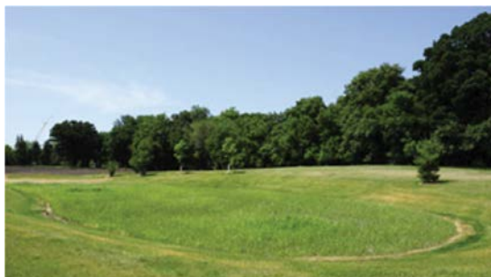
Slika 14.5: Depresija uređena za prihvatanje površinskog oticaja (Izvor: nwrn.eu)
