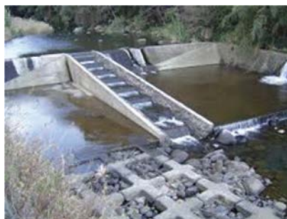
Slika 18.14: Tehnička riblja staza sa prelivanjem iz bazena u bazen (Izvor: hehuzhili.com)
