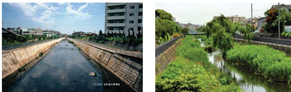
Slika 18.12: Primer renaturalizacije vodotoka – promena poprečnog profila reke Itači, Japan (Izvor: pwri.go.jp)
