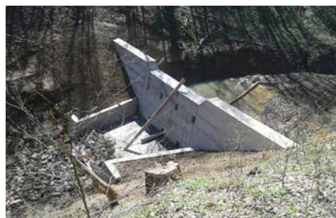
Slika 14.2: Betonska bujična pregrada (Izvor: Srbijavode)
